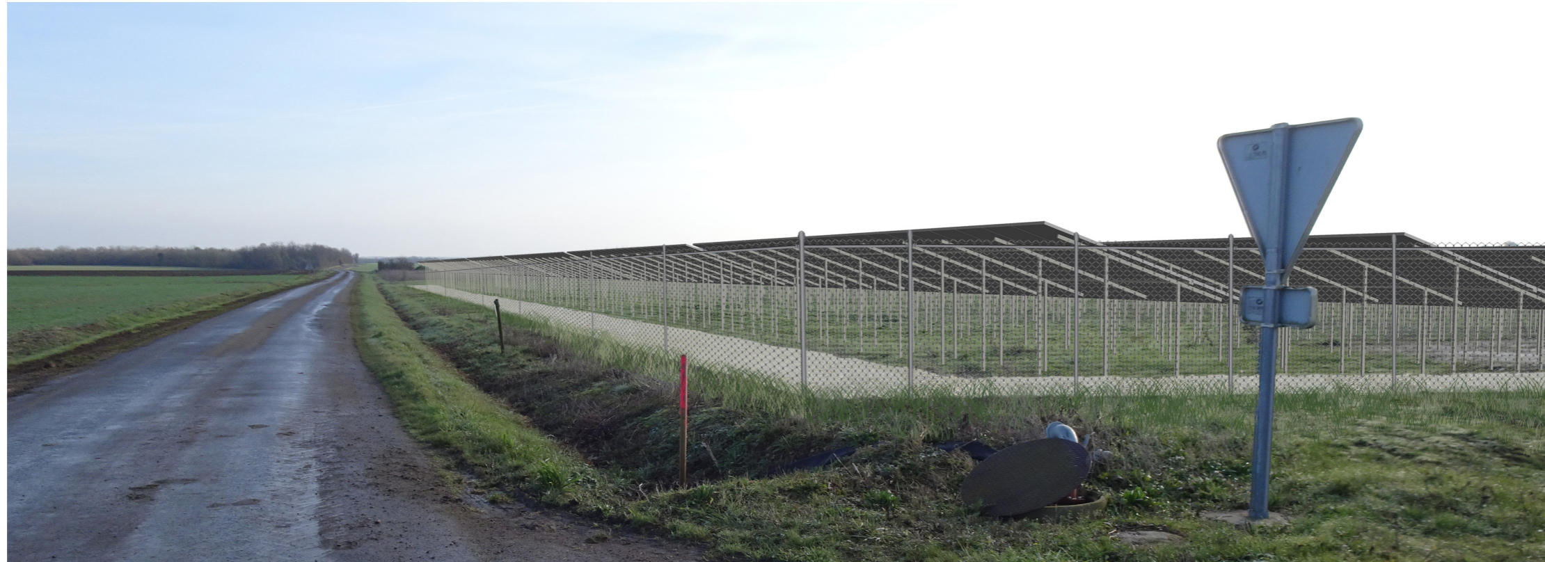
PV4 - Vue depuis la Route Départementale n°144 à l'angle nord-ouest du site
